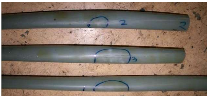
Viditelné bílé skvrny po odstranění polovodivé vrstvy, úsek č. 1, 2, 3
