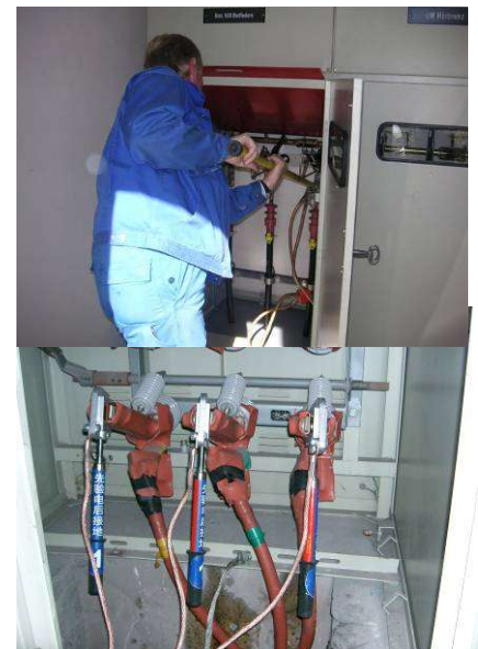
Obr. 4.1; Uzemnění všech fází
