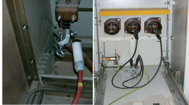
Obr. 4.5: Jednofázové připojení, uzemnění nepoužitých fází
