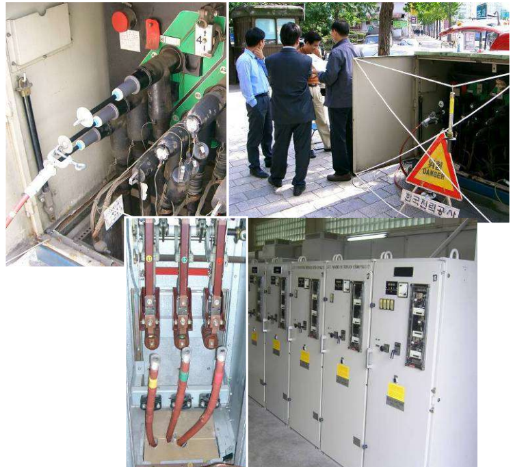
Obr. 4.4: Připojení k uzavřeným rozvodnám
