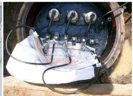
Obr. 5.25: Připojení můstku k dostupným plášťům ve spojovací skříni
