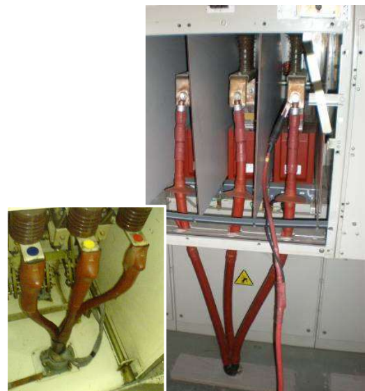
Obr. 8.8: Celý kabel není dostupný, použití režimu Expert umožňuje bezpečnou identifikaci kabelu
