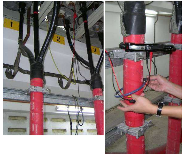
Obr. 8.6: Přístupná kabelová koncovka, kalibrace na plném průměru kabelu
