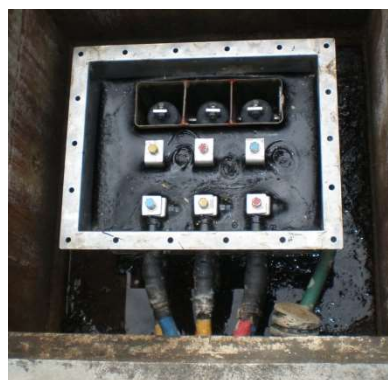
Obr. 9.7: Spojovací skříň s otevřenými konektory v 6814 m
