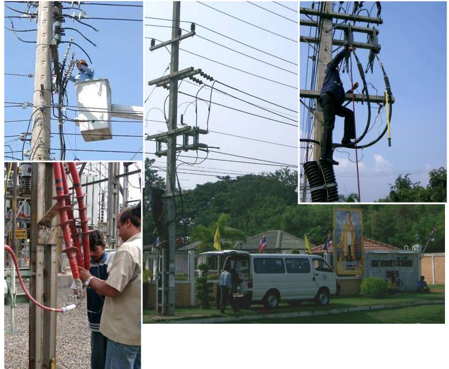
Obr. 4.3: Připojení ke kabelovým koncovkám na sloupech
