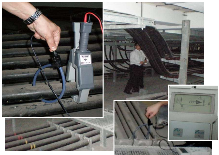
Obr. 8.3: Identifikace kabelu v terénní aplikaci
