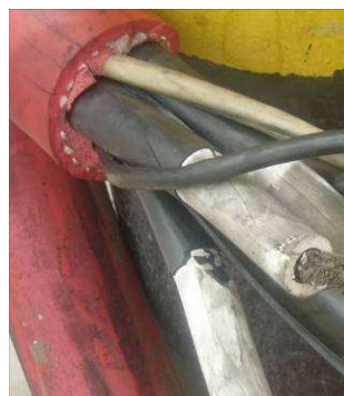
Obr. 2.3: 3žilový EPR, včetně datové linky, radiální typ
